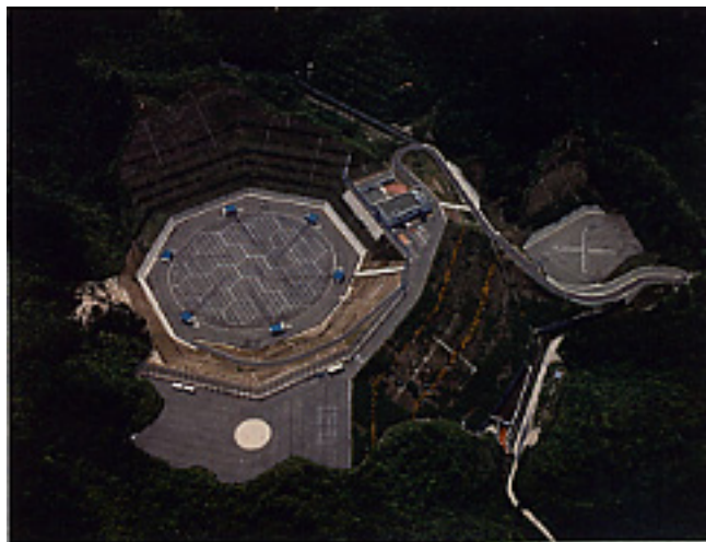
図2：MUレーダーの全景。中央の直径100メートルの円形内が八木アンテナアレイ。その周辺の6棟の建屋に475台の小型送受信機が収納されている。
