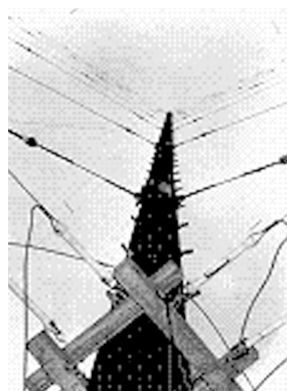
図1 日本電業工作株式会社により1964年頃建設された60m木柱直交2回巻きループアンテナ（VLF帯ホイッスラー空電観測用）
