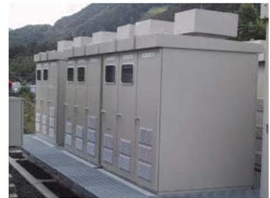
図7 直流電気鉄道の蓄電システム
