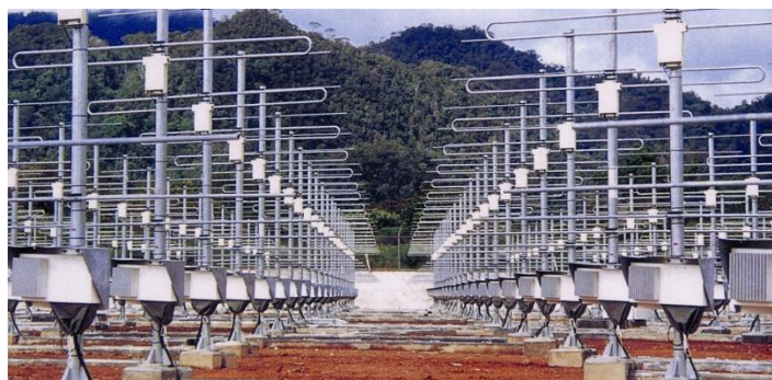
インドネシアの赤道大気レーダーの写真。八木アンテナ 560 本で直径 110m の巨大アンテナが作られています。
