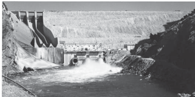
デルベンディカーン発電所遠景
