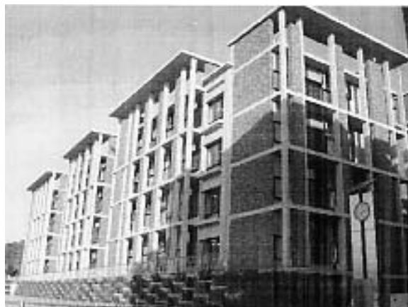
桂キャンパス A1 棟（電気系 2 専攻の研究棟）
