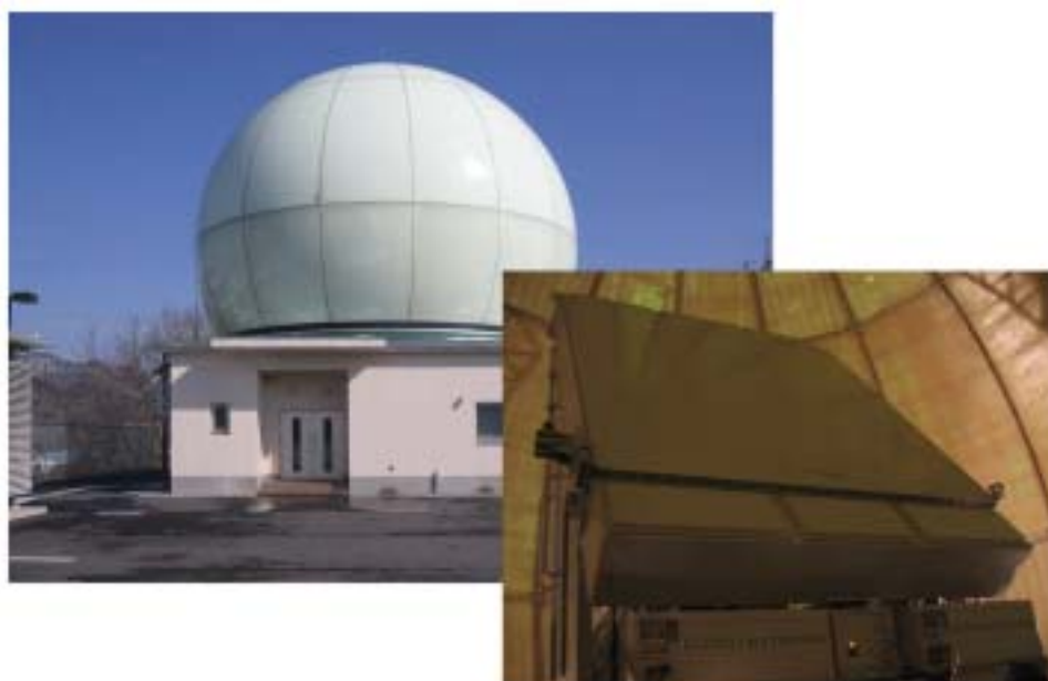
図3. スペースデブリ観測用レーダー（日本宇宙フォーラム上斎原スペースガードセンター）
