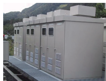
図7 直流電気鉄道の蓄電システム 写真提供 西日本旅客鉄道㈱
