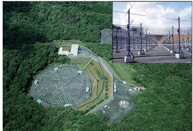
図4 MU レーダー全景写真と個々のアンテナの写真
