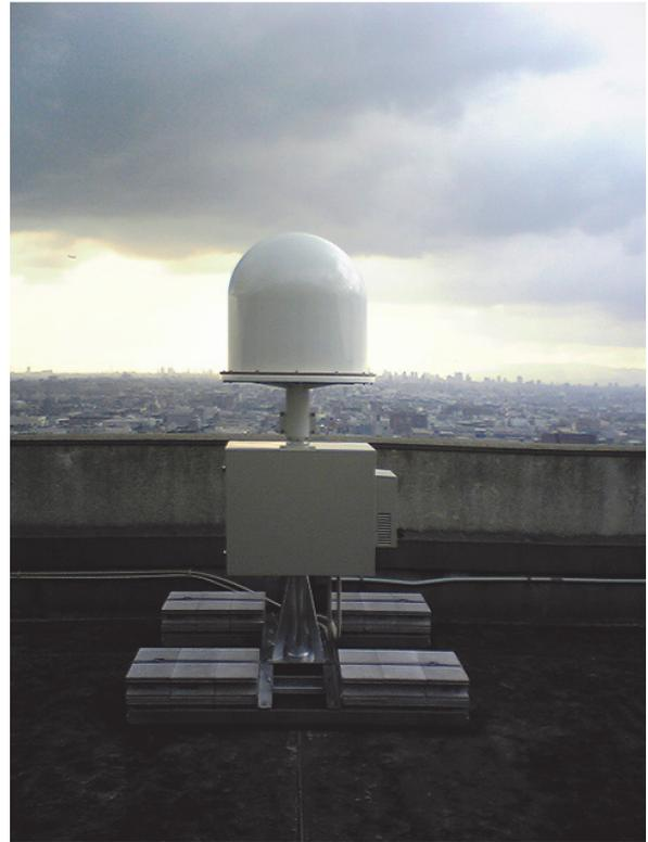
図5：WNI 気象レーダー「WITH レーダー」。
