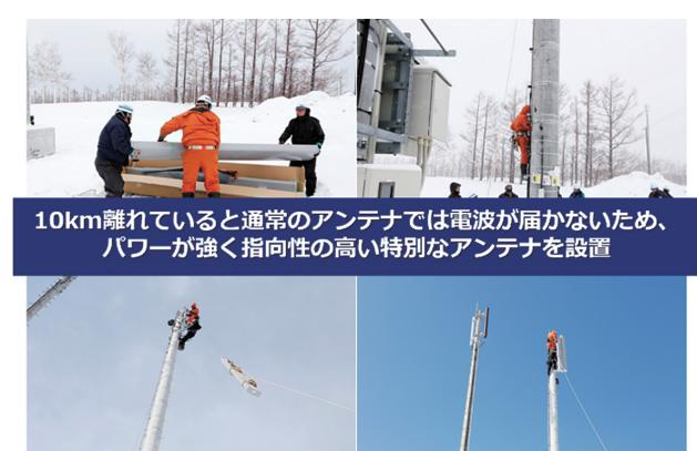
図 3 : 知床対策におけるアンテナ設置作業の様子
