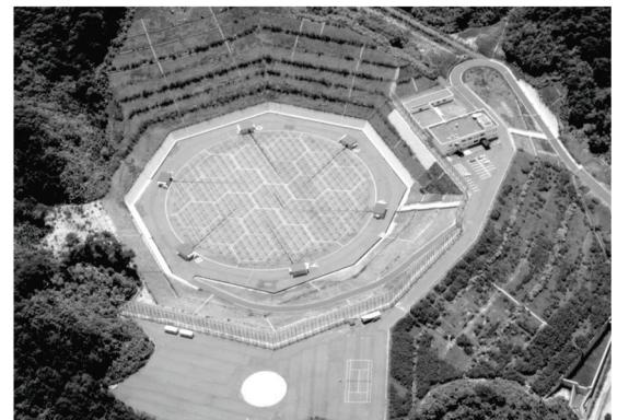
図2: MUレーダー。中央の円形の部分が475本の八木アンテナから構成されるフェーズドアレイアンテナ(直径103m)
