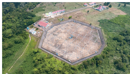
図1. 赤道大気レーダー (アンテナ直径110m)
